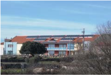
Solar Térmico AQS Peva, Guarda
